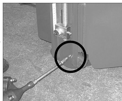
Smörjning av centrumrullarnas lager
